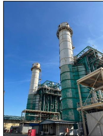
รูปที่ 2-2 ปล่องระบายอากาศเสีย สูง 53 เมตร
